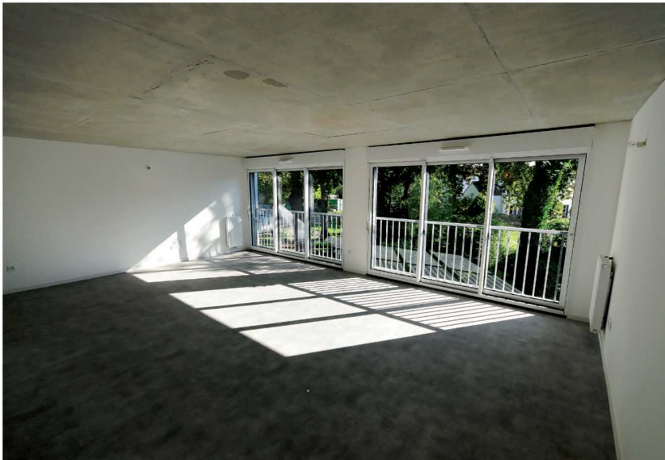
BEN, essentiel : logements avant livraison avec finitions brutes (plafond et sol béton) et sans partition des pièces.
