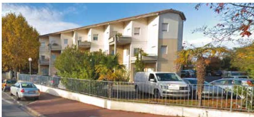
L'EHPAD comporte plusieurs bâtiments contigus construits en 2 phases (1982 et 1997). Les constructions reposent sur un niveau partiel en sous-sol et s'élèvent en R+3. Elles peuvent accueillir 204 personnes réparties dans 134 chambres à 1 lit de 17 m<sup>2</sup> et 35 chambres à 2 lits de 22 m<sup>2</sup> toutes équipées de douche privative.
