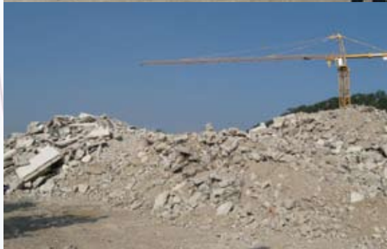
Concassage des bétons
