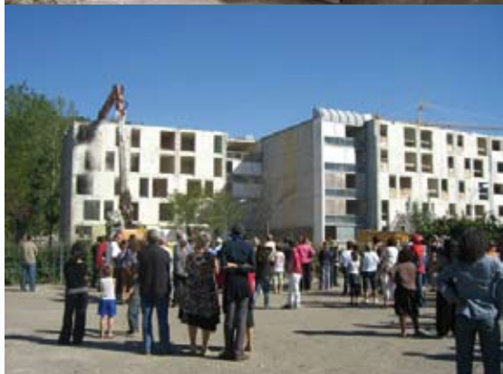
Démolition par grignotage
